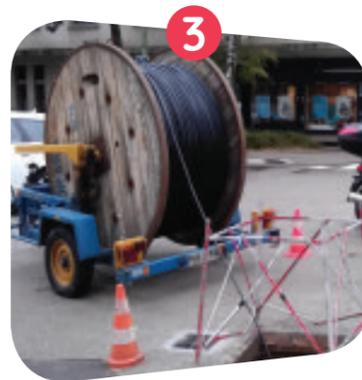
Une fois enroulés, les câbles de fibre optique vont être **déployés sur le territoire jusqu'aux logements des abonnés**. Les techniciens vont connecter les câbles de fibre depuis les Sous-Répartiteurs Optiques jusqu'au Point de Branchement Optique chez l'abonné.
